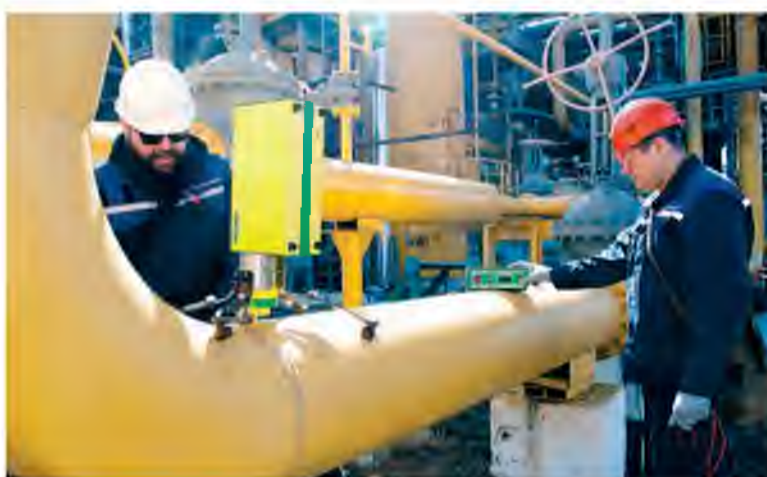
Дефектоскописты Дмитрий Красюков и Александр Нефёдов устанавливают рентген-аппарат и кассеты с пленкой на трубопровод на агрегате №3
